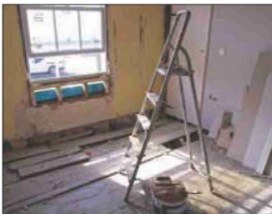
Lavori di ristrutturazione
