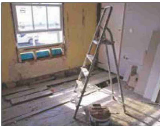
Lavori di ristrutturazione
